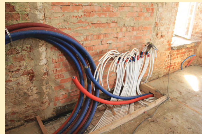
Ремонтно-восстановительные работы в храме. Фото 2016 года
