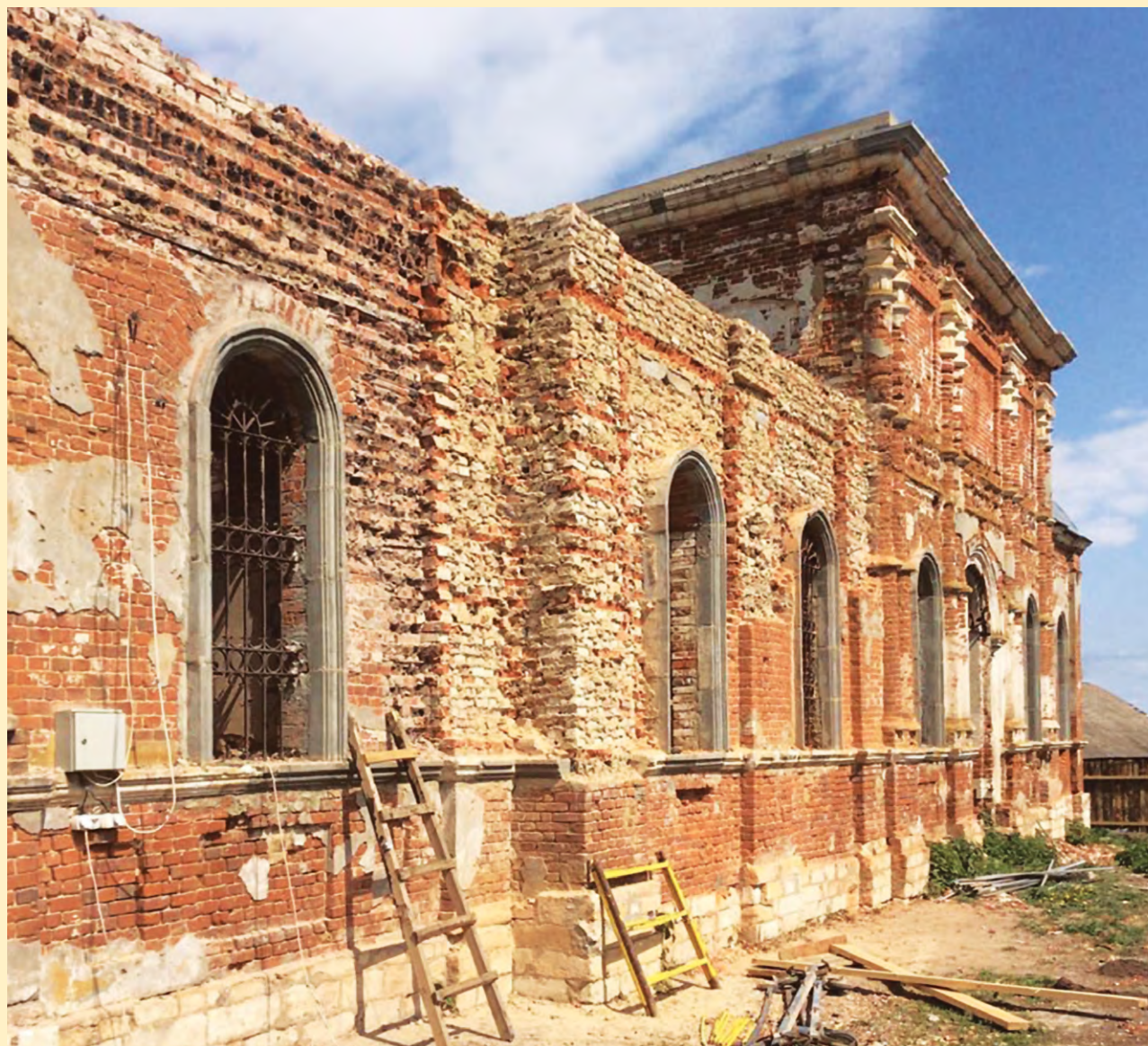
Работы па расчыстцы сцен і вычыстцы кирпичнай кладкі
