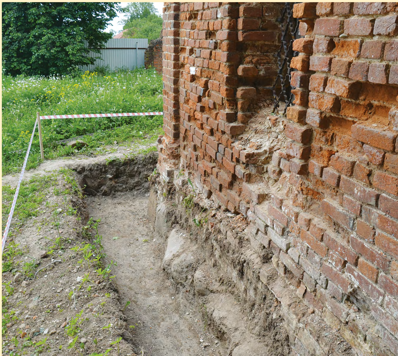
Фундамент храма после расчистки. Фото 2016 года
