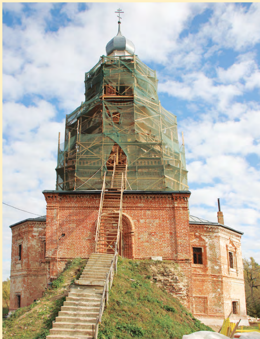
Реставрационные работы в Вознесенском храме. Фото 2015 года
